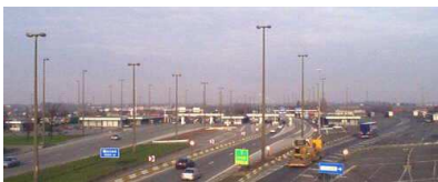
POSTE FRONTIERE DE REKKEM
